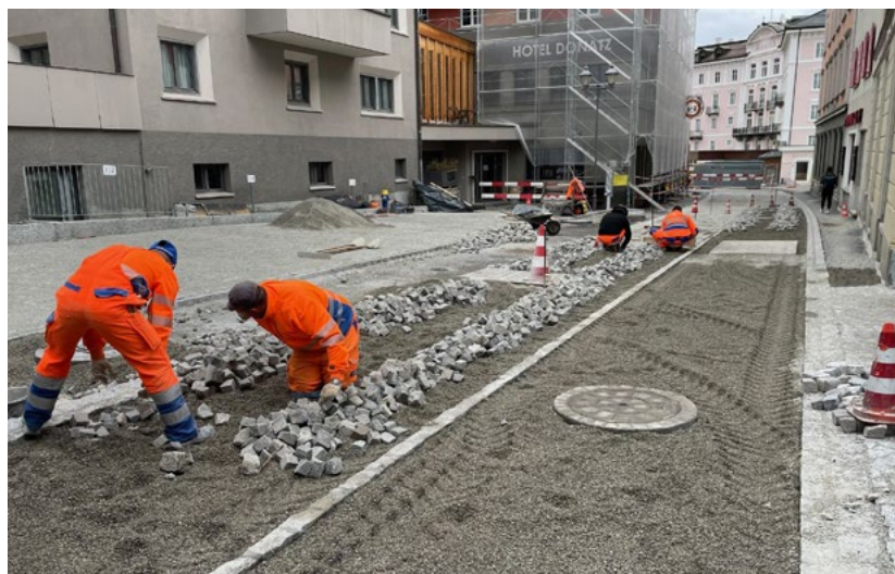
Einbau der Pflasterung
