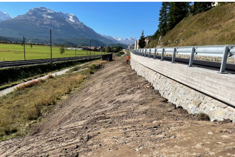
Sanierte Mauer mit Bruchsteinverkleidung
