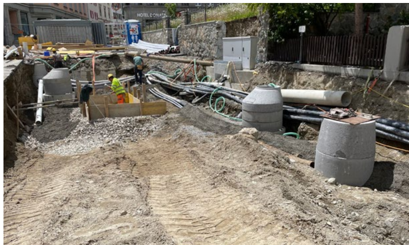
Komplexe Baustelle auf engstem Raum
