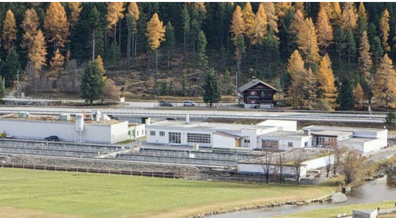
Die ARA Staz in Celerina wurde zurückgebaut
