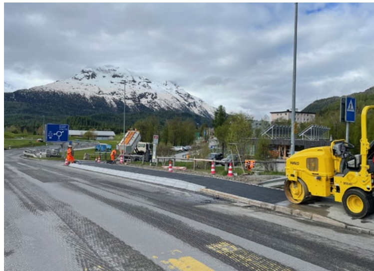
Sanierte Bushaltestellen Golf und Ariefa
