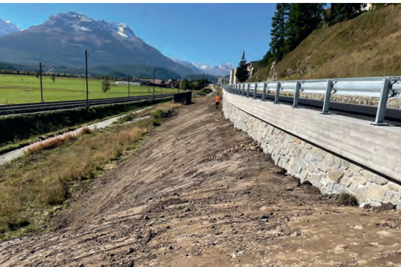
Sanierte Mauer mit Bruchsteinverkleidung
