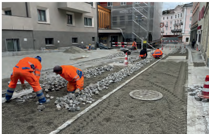
Einbau der Pflasterung
