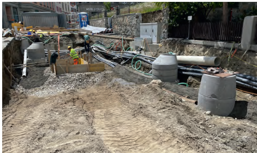
Komplexe Baustelle auf engstem Raum
