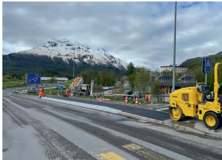
Sanierte Bushaltestellen Golf und Ariefa
