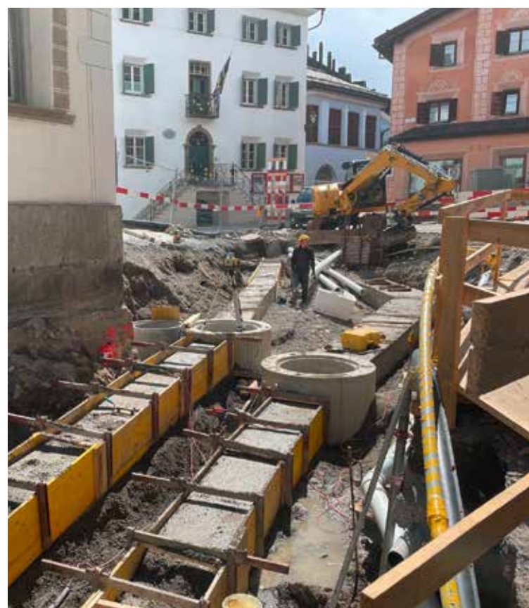
Enge Platzverhältnisse in Plazzet
