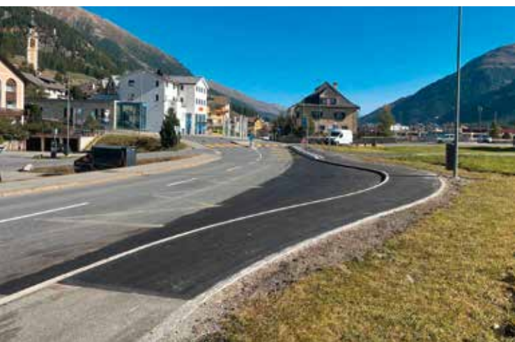
Sanierte Bushaltestelle Sper l'En
