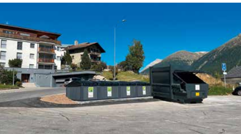
Sammelstelle Sur Puoz mit Halbunterflursystem und Pressmulde
