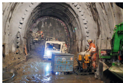
Foto: Spinas, Tunnelvortrieb im Schutz eines Rohrschirmes
