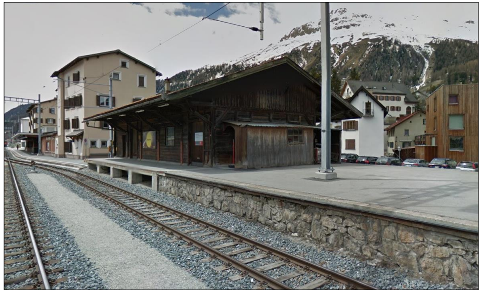
Güterschuppen Samedan, Ansicht Ost (Google Street View)
