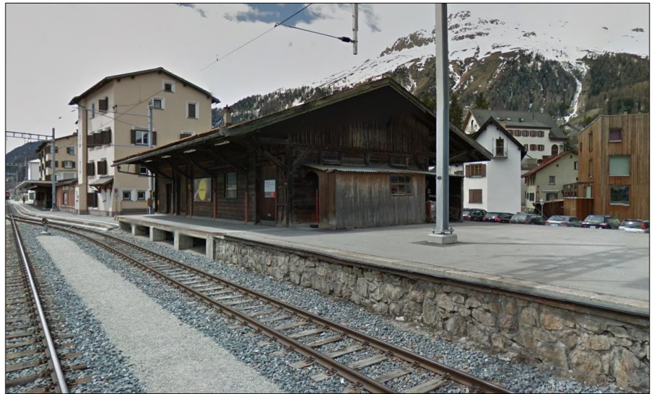
Güterschuppen Samedan, Ansicht Ost (Google Street View)
