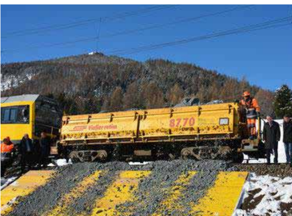
Der erste Güterwagen mit Ausbruchmaterial wird geschüttet
