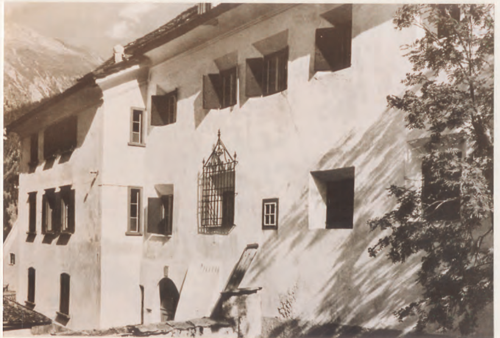
Die nördliche Seitenfassade des Plantahauses parallel zur Via Mulins.
