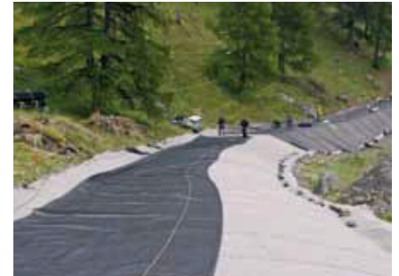
Obere Filzlage und Verlegung Geogitter
