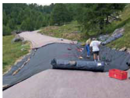
v. unten n. oben: untere Filzlage / Abdichtung / obere Filzlage
