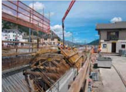
Am Baulosende in Richtung Celerina kommen nun Felspartien in der Baugrube zum Vorschein, welche mittels Sprengung beseitigt werden. Hierzu wurde ein Erschütterungsmessgerät in einem der anliegenden Gebäude installiert.
