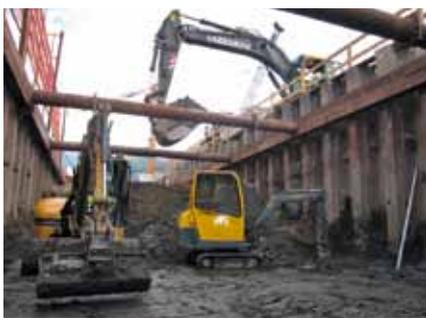
Ende Mai hat dann die Arge RhB Cristansains (Lazzarini, Pitsch) damit begonnen, Spundwände bis 14 m in den Boden zu treiben. Zusätzlich wurden noch Brunnen gebohrt, um das Grundwasser abzusenken. Diese Massnahmen sind nötig, um das Grundwasser von der Baugrube fernzuhalten. Seit Mitte Juni wird nun fast täglich betonierte, um den strengen Zeitvorgaben der Bauherrschaft gerecht zu werden. Am 04. August wurde demzu-
