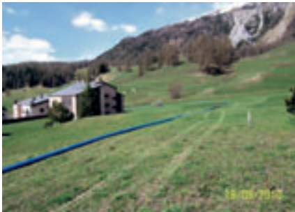
Leitung zusammengeschweisst und zum Einzug bereit
