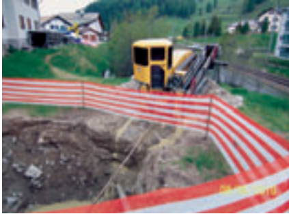
Bohrmaschine mit Bohrgestänge im Vordergrund
