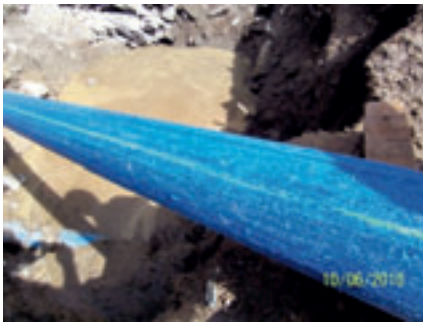
Stark beanspruchter Schutzmantel nach Rohreinzug
