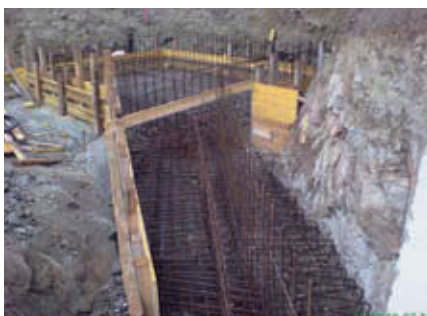
Nach den Armierungsarbeiten für das neue Kehrichthaus Via Nouva
