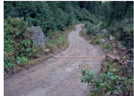
Foto an gleicher Stelle nach dem Unterhalt
