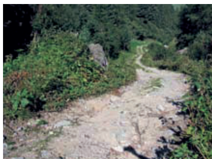
Steilstes Teilstück mit einer Längsneigung von über 25% vor dem Unterhalt
