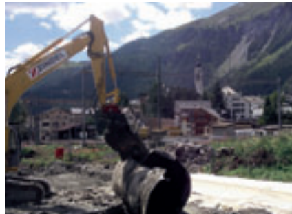
Während der heiklen Abbrucharbeiten
