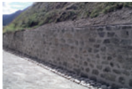
Die fertige Mauer
