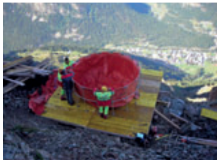
Montage des Wasserbeckens am Muot da Barba Peider, Fassungsvermögen 8 m 3 .
