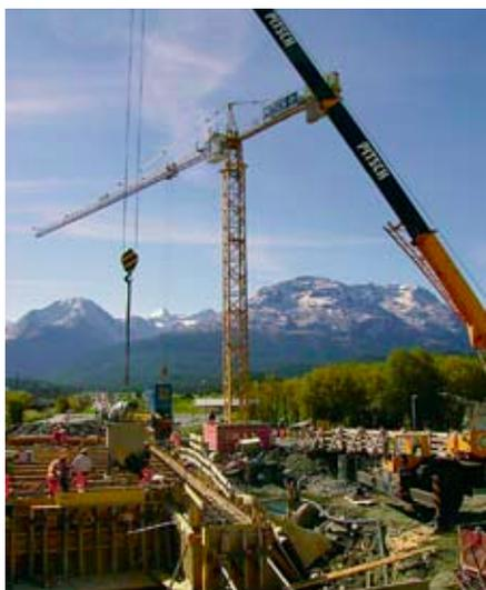
Ohne Arbeitsunterbruch wurde der Beton eingegossen und um 18.20 Uhr bei Sonnenuntergang der letzte Kübel Beton eingebracht. Um den frischen Beton vor dem Austrocknen und Einfrieren zu schützen, wurde noch in den Abendstunden die gesamte Brückenoberfläche fertig abgedeckt. Die letzten Arbeiten konnten um 23 Uhr abgeschlossen werden.
