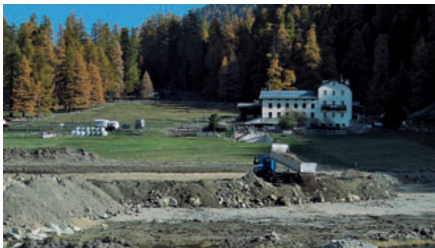
Die Deponie beim Landwirtschaftsbetrieb Klainguti.
