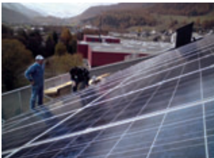
Montage der Photovoltaik-Anlage
