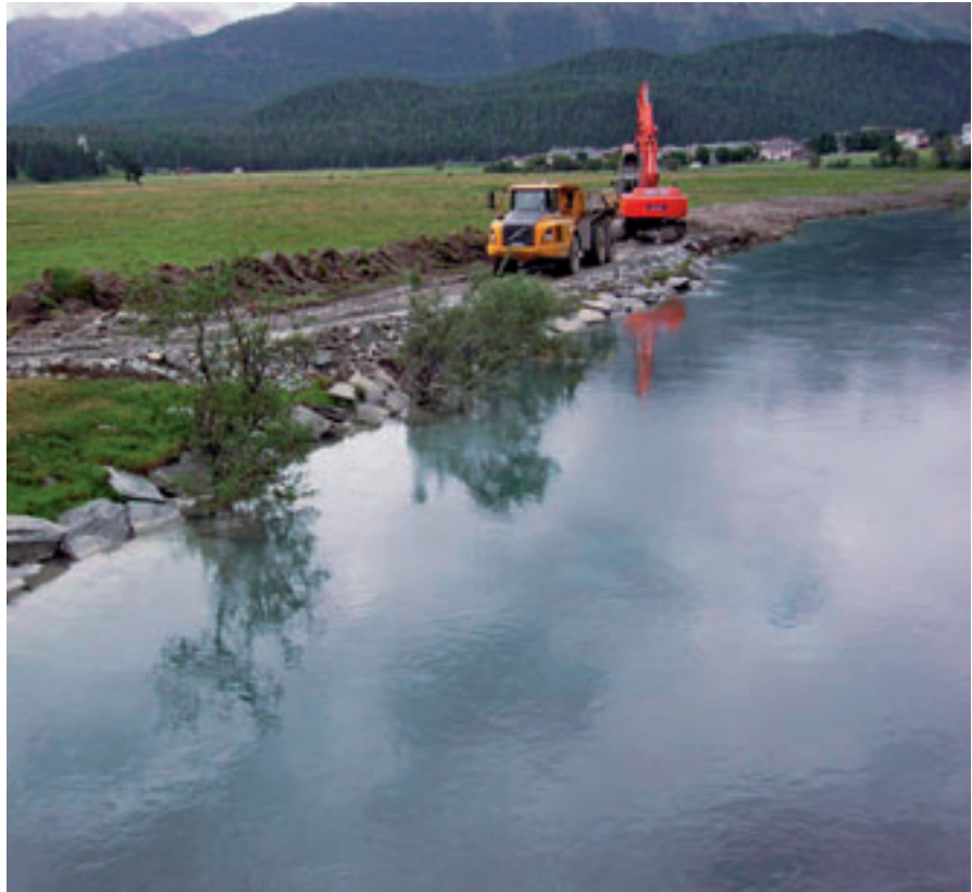
Altes, mit Steinplatten verbautes Ufer und neuer Uferverlauf bei Punt dals Bovs: Wenn im kommenden Jahr die Vegetation wieder nachgewachsen ist, wird sich die bisher starre Uferlinie dieses Innabschnitts zu einem abwechslungsreichen Naturufer entwickelt haben.
