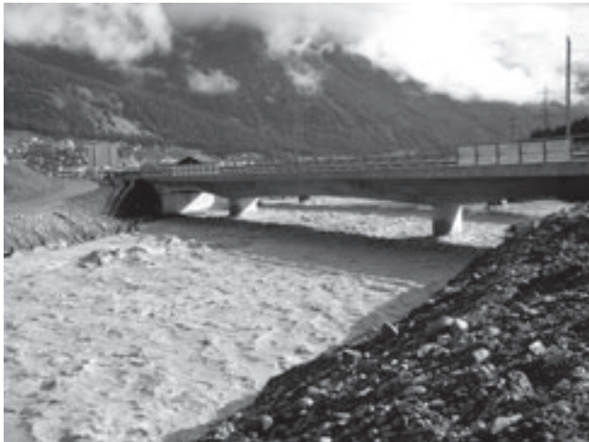
Hochwasserführender Flaz bei der neuerstellten Brücke für die Kantonsstrasse.
