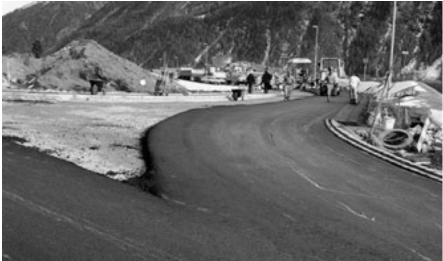
Belagszusammenschluss der Tragschicht HMT 22 bei der Einmündung kleine Umfahrung in die Via San Bastiaun.
