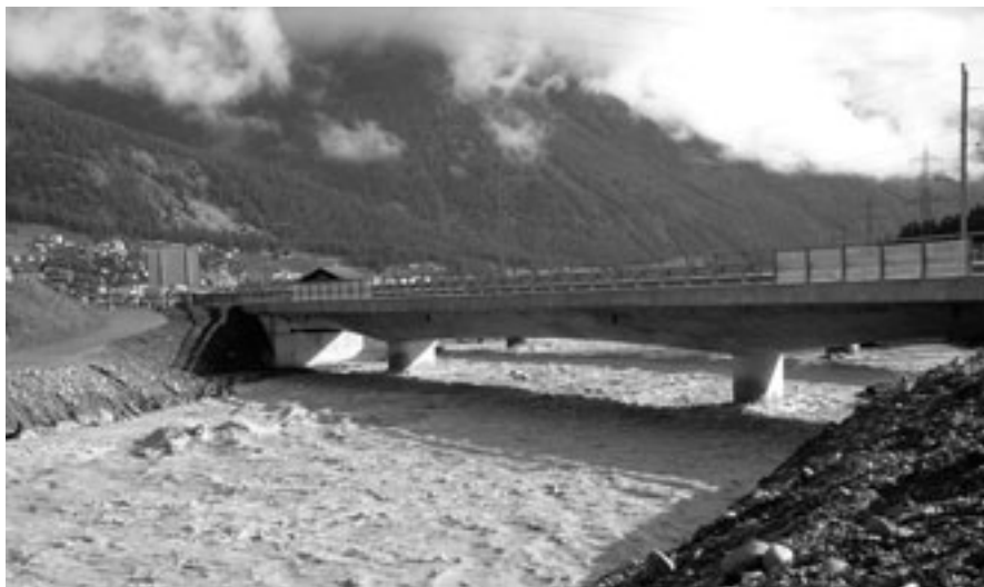
Hochwasser führender Flaz bei der neuerstellten Brücke für die Kantonsstrasse.
