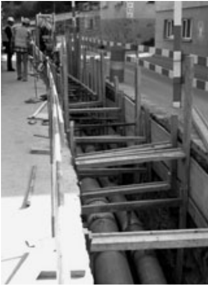
Neue Linienführung für Meteorleitung Ovel und Kanalisationsleitung Teil des Dorfkerns in der Via Retica.
