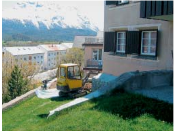
Weiterausbau im Gebiet Crappun
